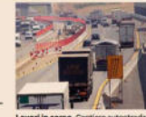
Lavori in corso. Cantiere autostradale
